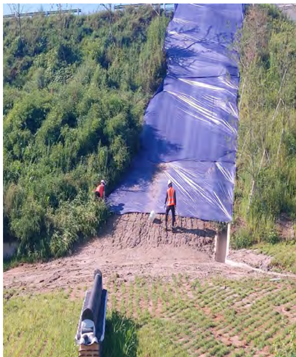
취약지구 토사 붕괴 예방 작업
