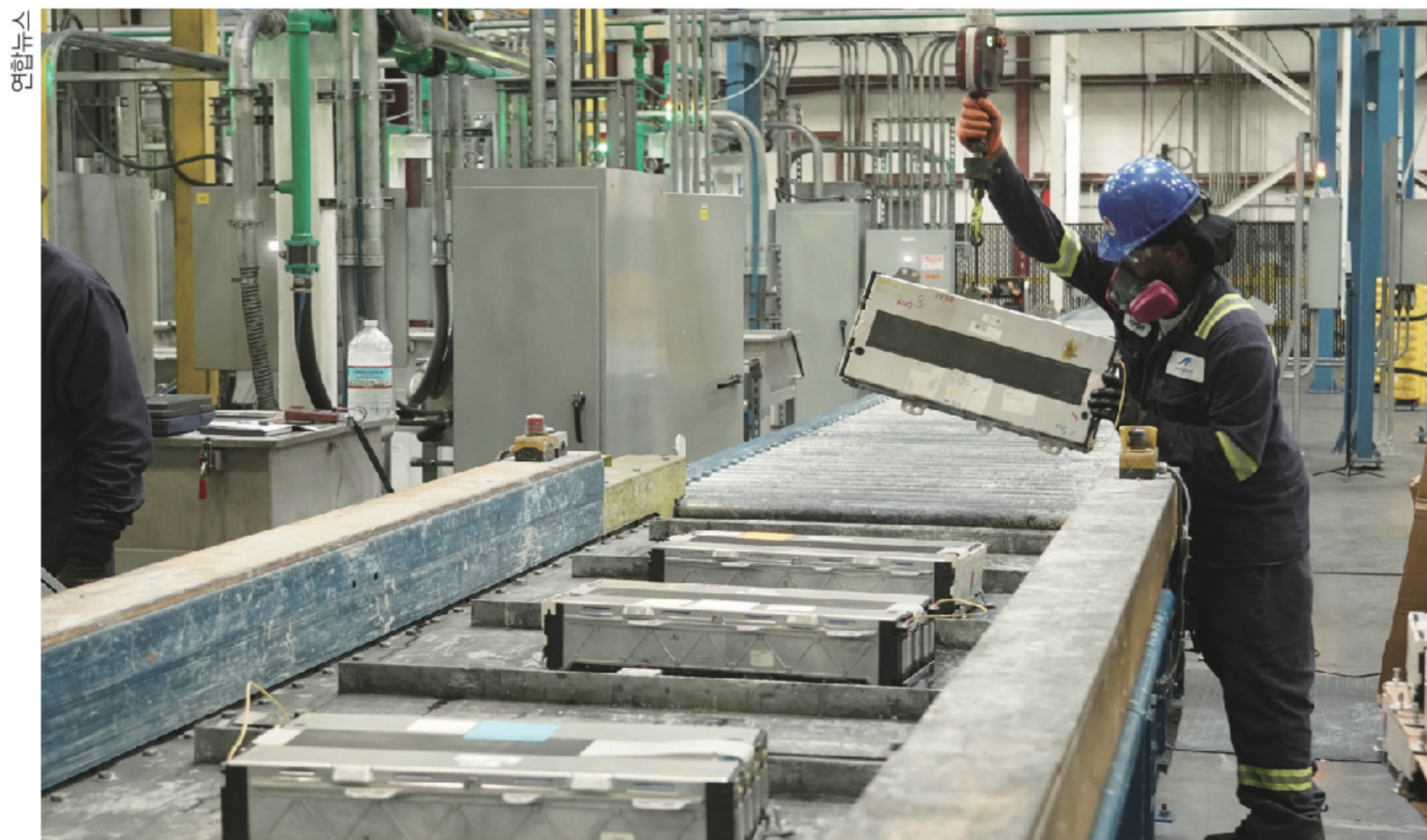
폐배터리 리사이클링업체 어센드 엘리먼트의 시설 내부
