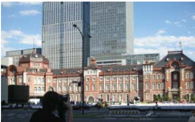
東京駅の容積率は周辺の6棟のビルへ移転された
