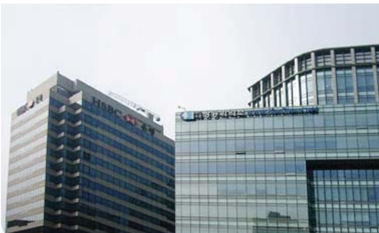
왼편 강북사무소 HSBC 빌딩과 오른편 본사 상공회의소 빌딩
